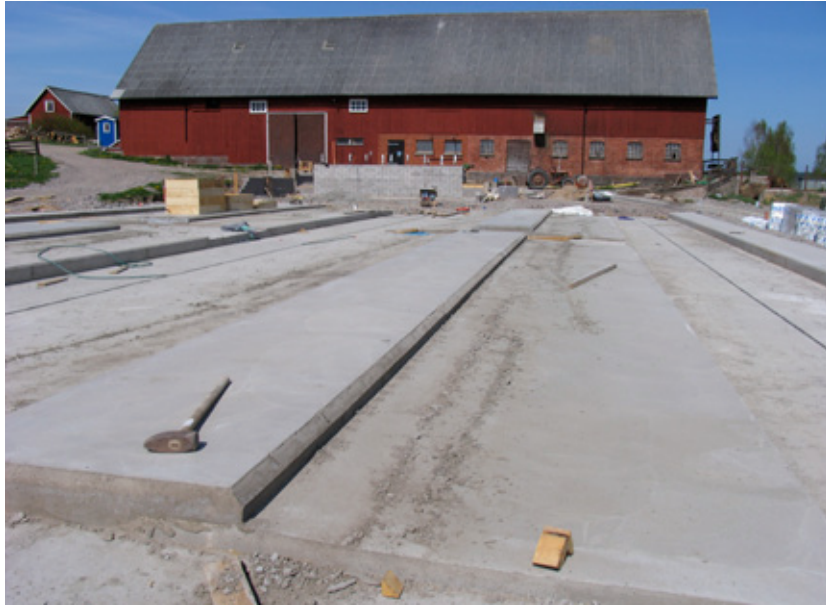
Här ser vi en av tre gödselrännor av tre som går genom hela stallen.
