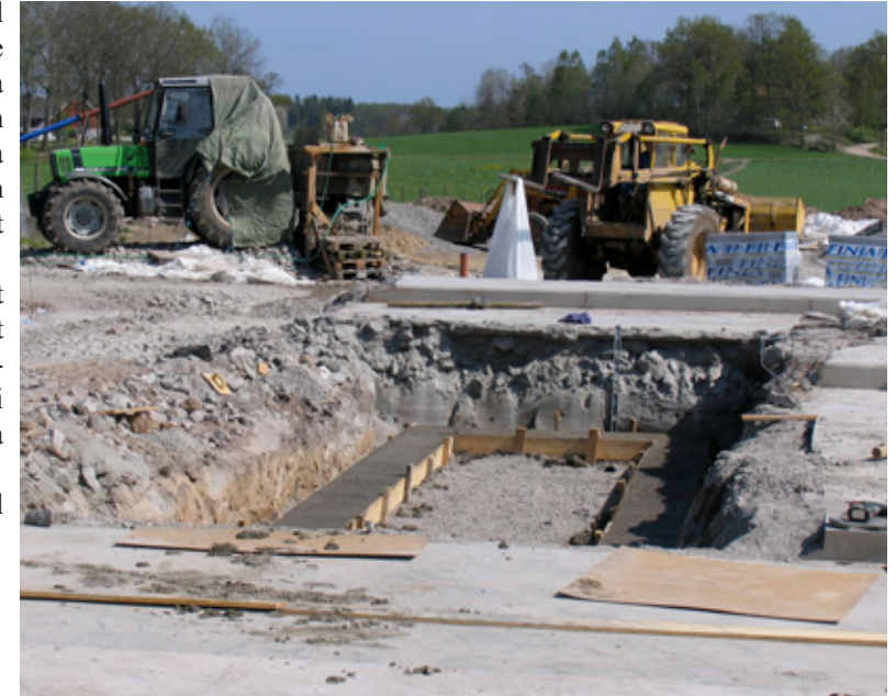
Denna grop som Anders Berggren grävde ut i veckan skall bli en mjölkgrop där 14 kor kommer att stå i fiskbensmönster vid mjökningen.
