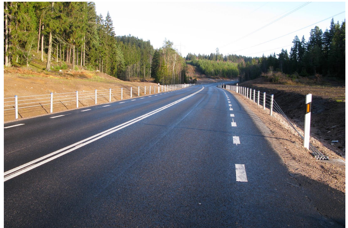
Färdig väg från väster under Harsprångsledningen.
