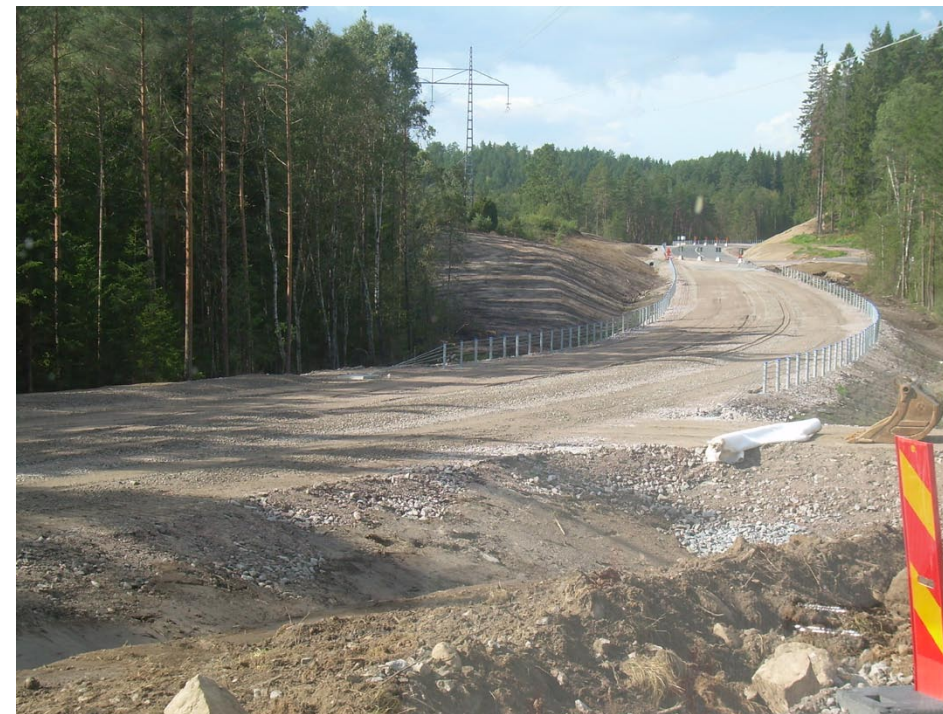
Nya vägen under byggnation från öster förbi Harsprångsledningen
