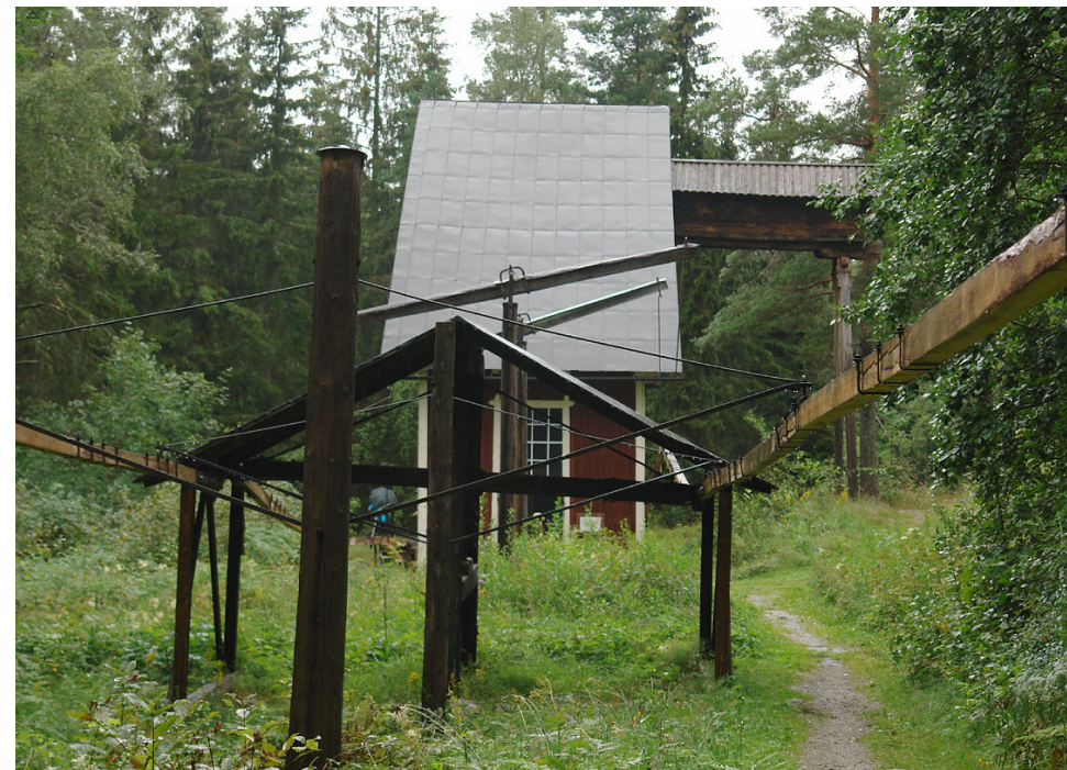
Stånggången som gick till en gruva 3,5 km därifrån och drev vattenpumpar kommer från vattenhjulet som numera är inbyggt i huset.
