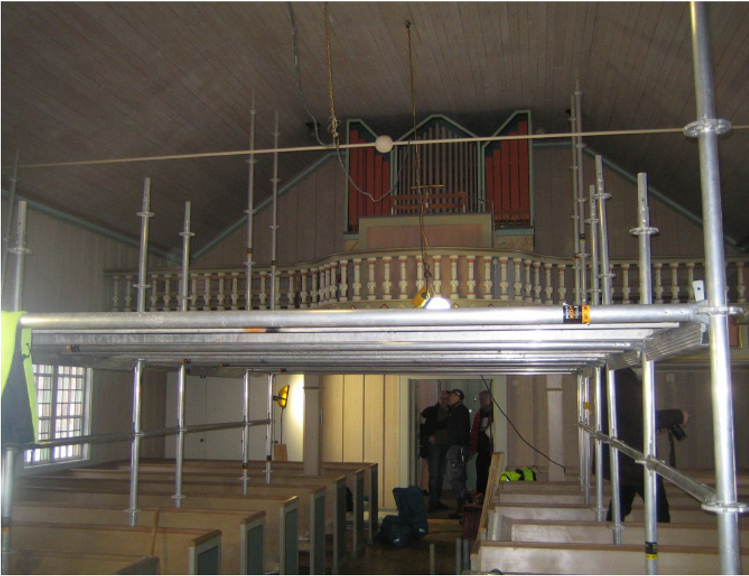
Hela kyrkan var full av ställningar när tak och väggar målades.
